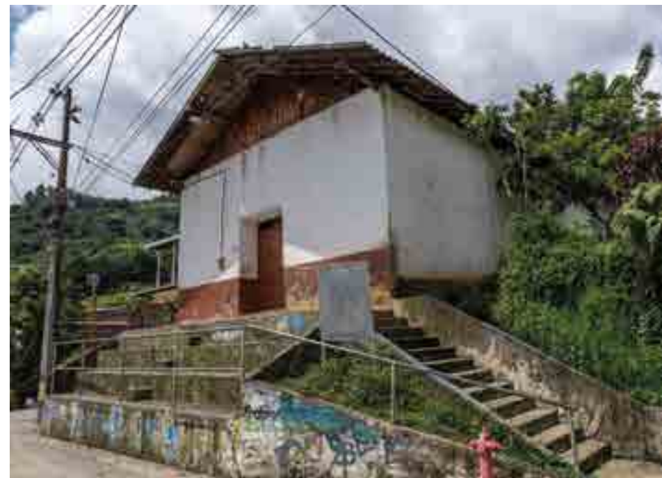
➡ Iglesia de La Aldea. Su construcción inició en 1742.
